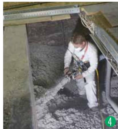
Bei der Aufsprühtechnik wird der Zellulosedämmung mittels einer speziellen Düse Wasser beigemischt. Mit diesem Gemisch lassen sich gewölbte Flächen ohne Fugen und Verschnitt in einer definierten Stärke dämmen.
