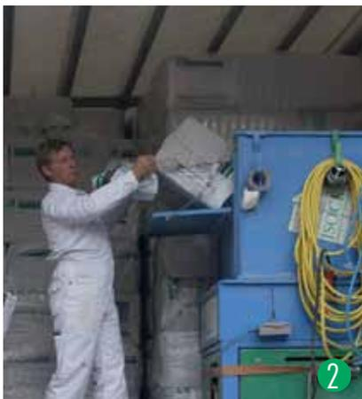
Dämmmaterial und Maschine bringt der Fachmann am LKW mit - kein Lagerproblem auf der Baustelle. Ein Mitarbeiter befüllt die Einblasma-schine im LKW kontinuierlich mit Zellulose.
