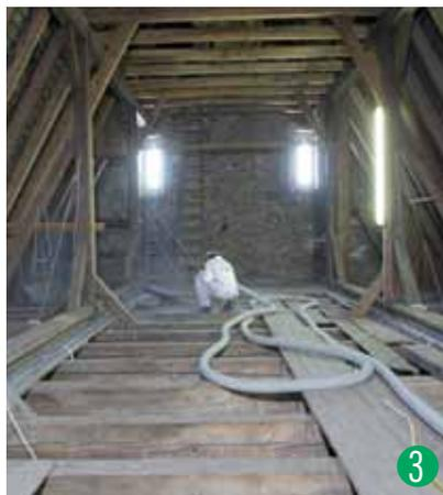
Im Dachraum steuert der Einblasfachmann den Materialfluss mittels Funk.
