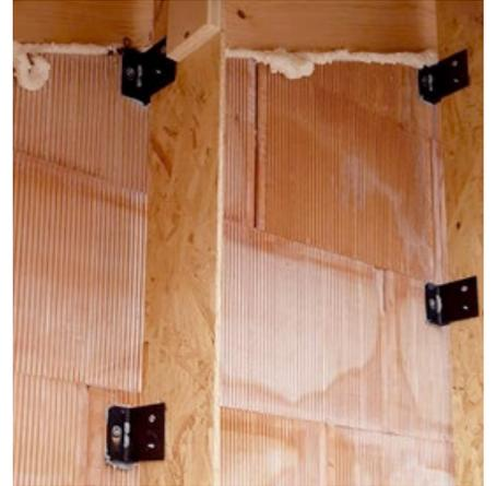
Das Ständersystem aus Holzwerkstoffplatten wird mittels speziellen Abstandhaltern fixiert und in einer Flucht eingerichtet. Unebenheiten des Untergrunds können durch dieses System ausgeglichen werden.
