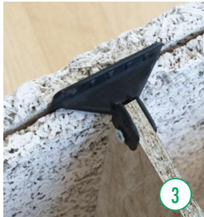
In die lotrecht ausgerichteten Abstandhalter wird die Fassadenplatte eingehängt. Die fertige Oberfläche ist plangeschliffen und damit ein optimaler Untergrund für die folgende Putzbeschichtung.
