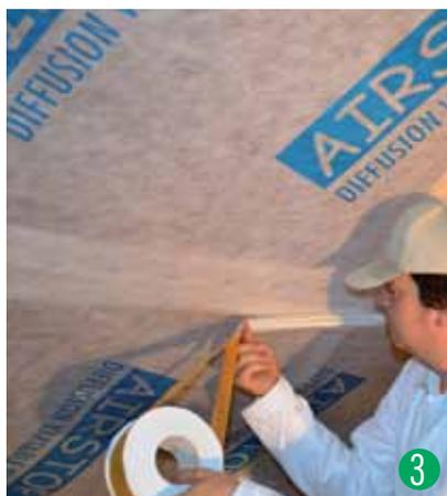
Ganz wichtig ist die luftdichte Verklebung und Abdichtung von Überlappungen, Anschlüssen und Durchdringungen. Siehe dazu die Broschüre „Luftdichtheit im Detail“.
