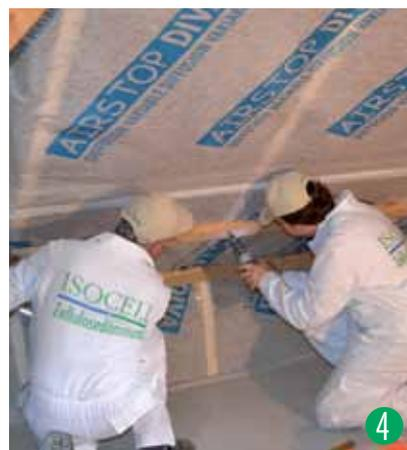
Nun werden die Latten im Achsabstand von ca. 30 cm angebracht. Im Idealfall wird die Lattung direkt auf der Stoßverkleidung positioniert, um die Klebestellen zusätzlich zu entlasten.
