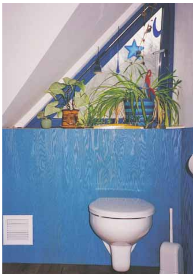
Bild 10: Holz statt Keramik: Fassadensperrholz als Vorwandbekleidung
