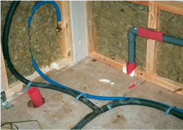
Bild 2: Typische Baustellen-situation bei Verarbeitung durch Installateur
