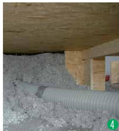
Danach wird der Aufbau mit der ISOCELL Zellulose verfüllt.
