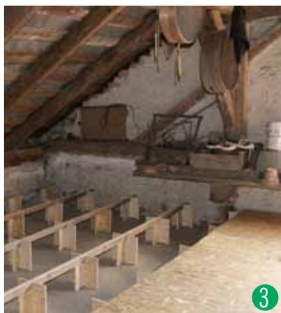
Die Bodenplatten verlegen und befestigen. Die Konstruktion ist mit einer 18 mm OSB Holzwerkstoffplatte ein begehbare und äußerst tragfähiges System.
