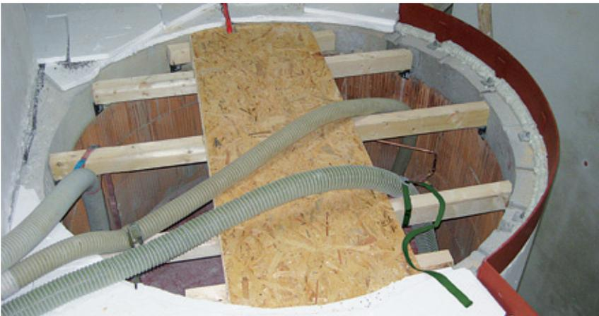
Vor dem Einblasen ist der Kessel noch warm zu prüfen. Das Ausblasen selbst erfolgt dann im ausgekühlten Zustand, damit bei einer Dimensionsänderung keine Hohlräume entstehen können.
