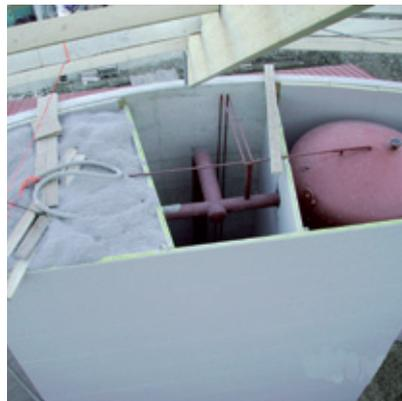
Für ein Heizkraftwerk in Laßnitzhöhe wurden 2 Pufferspeicher mit einem Gesamtvolumen von 200.000 Litern von der Firma Peterka mit ISOCELL Zellulose gedämmt.
