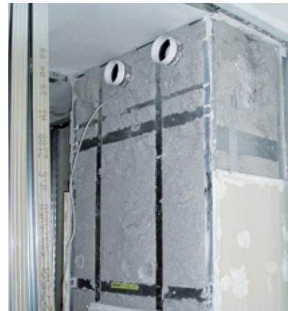
Beim Dämmen von Schächten kann auch eine Lanze eingesetzt werden. Am Bild ein ausgeblasener Schacht mit abgenommener Verkleidung. Die Zellulose füllt auch noch die kleinsten Ritzen. Ein optimales Ergebnis.
